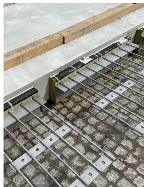
Per le solette prefabbricate dei balconi, completamente aggettanti, servivano dei solidi connettori per ancorarle all'edificio esistente.
