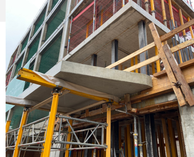
L'ancoraggio della soletta prefabbricata all'edificio ha richiesto una procedura di montaggio precisa ed eseguita a regola d'arte.
