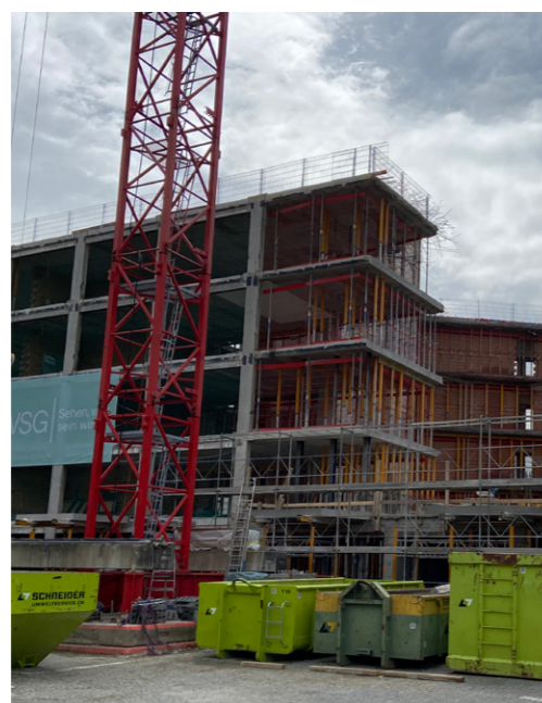
L'edificio in cemento armato degli anni '90 è stato smantellato fino a far emergere la struttura portante.
