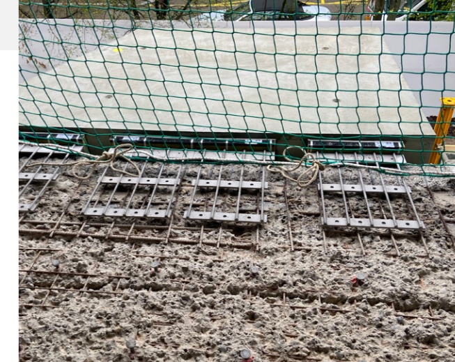
Un lavoro minuzioso: per fissare i balconi è stato necessario rimuovere lo strato di calcestruzzo fino all'armatura.
