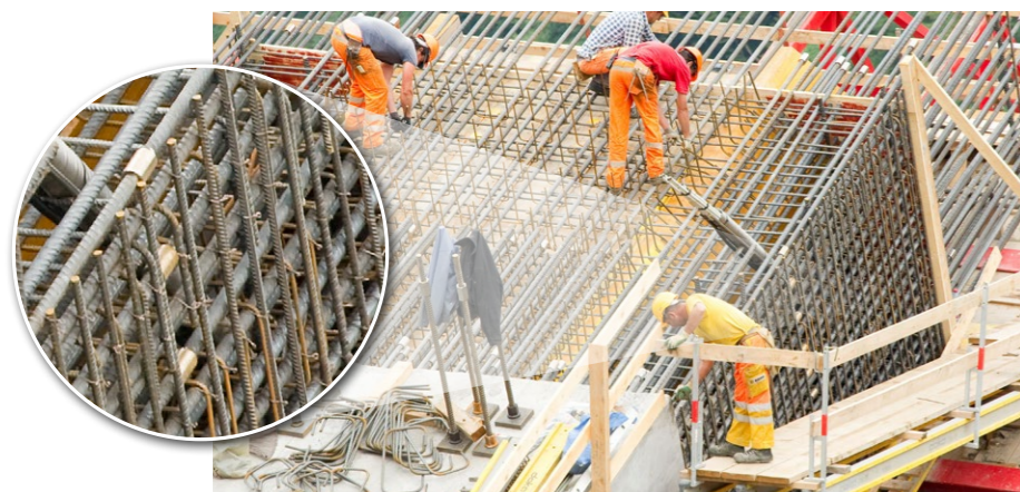
Grazie alle dimensioni compatte i giunti BARTEC® sono adatti anche per armature ad elevata densità.
