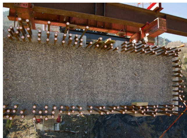
Nel colmo dell'arco la cassaforma è a sezione rettangolare.
