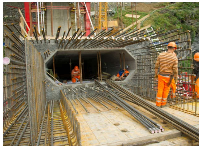
Le spalle supportano la struttura cava dell'arco.
