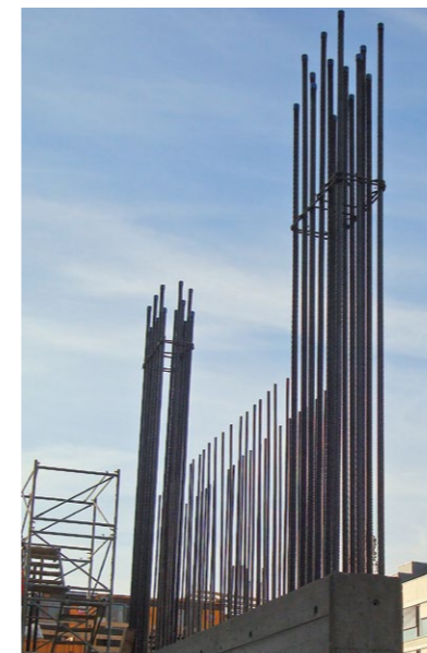
Parete antisismica con alta densità d'armatura ai lati.
