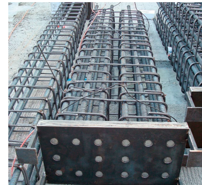
Speciale lastra BARTEC® CT per ancoraggi multipli.
