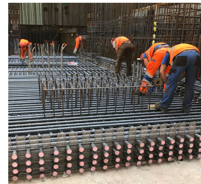
A costruzione terminata la platea è composta da 22 strati di ferro d'armatura e ha uno spessore di 2,5 m.
