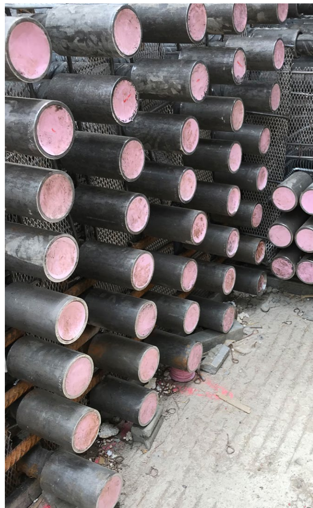
L'impossibilità di applicare il metodo di costruzione tradizionale mediante sovrapposizione delle armature impone il ricorso ai giunti a vite BARTEC®.
