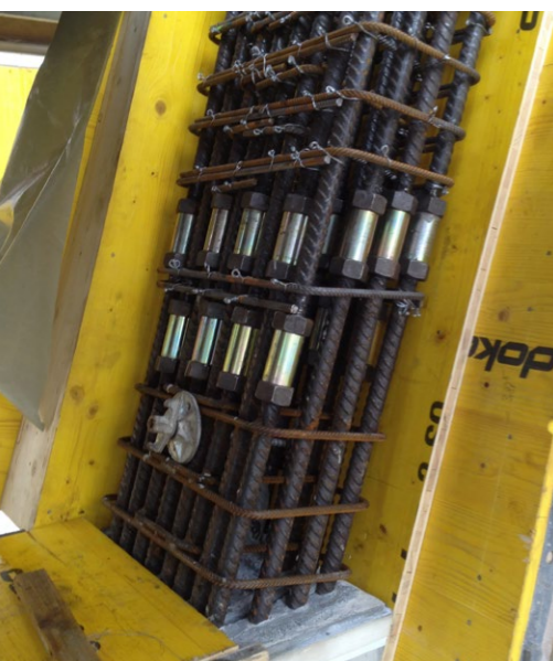
Ottimo risultato nel calcestruzzo a vista nonostante la struttura estremamente leggera.
