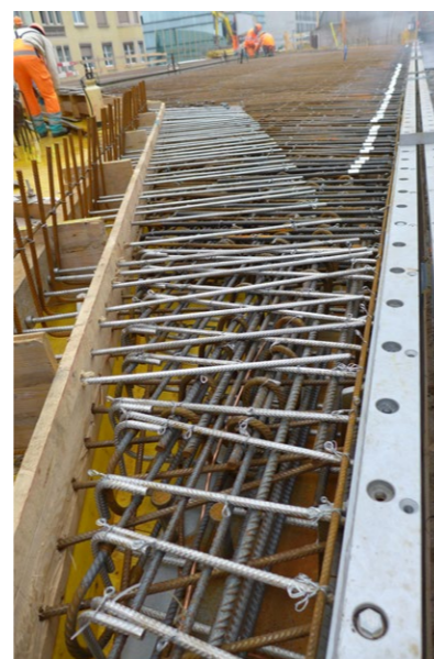
Acciaio d'armatura inox Top12 con BARTEC®.
