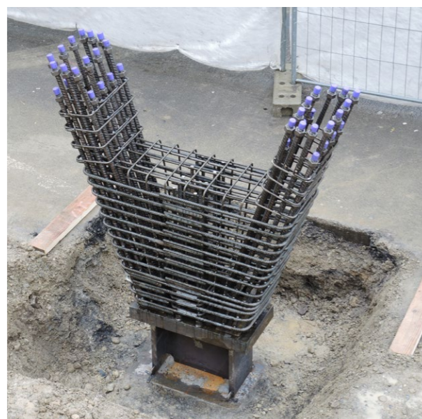
Armatura di sostegno ad alta resistenza Top700 con giunti a vite BARTEC® TOP.
