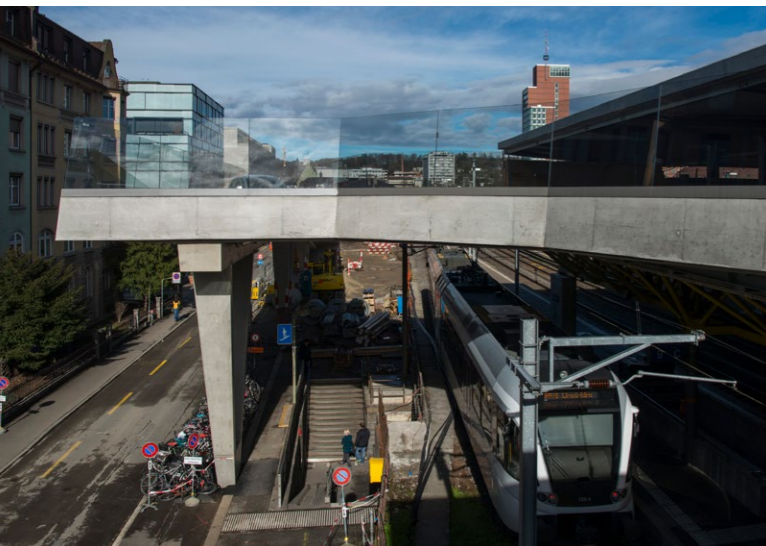
La nuova rampa d'accesso a due corsie dell'autosilo alla stazione ferroviaria di Winterthur.
