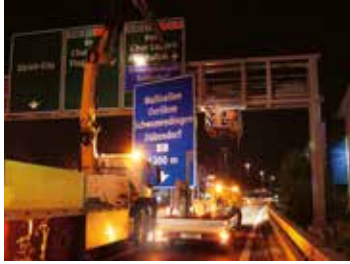
Anpassung der Markierung und der Signalisation an der A1, Ausfahrt Wallisellen. Coverfoto von Basil Bleuler/Astra
