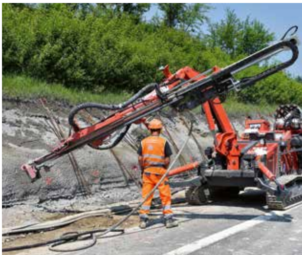
Oben: Sanierung des Ölrückhaltebeckens Pneumatti an der Überlandstrasse.
