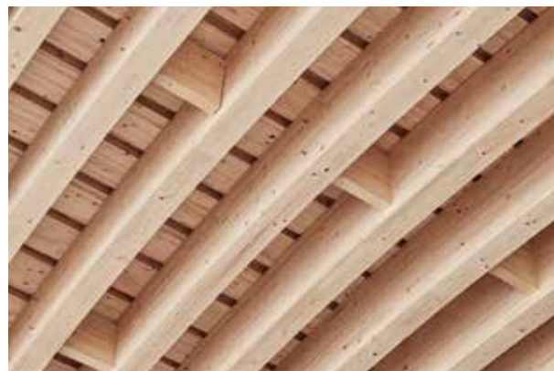
Untersicht mit Dachbinder, Kipphalterungen und Sekundärtragwerk.
