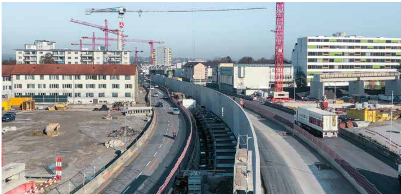
Blick Richtung Osten auf die Baustelle. Die Mittelwand der Einhausung steht bereits. Die Installationsflächen der Strassenbaustelle sind nicht zu unterschätzen (vgl. auch Plan S. 36–37).
