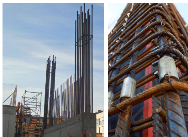
Mur parasismique avec armatures latérales concentrées.
