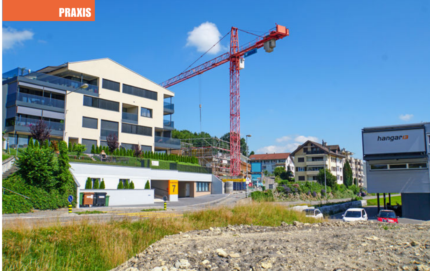
Eine Verdichtung mit neun Familienwohnungen: Wo früher nur ein Einfamilienhaus stand, baut die Stiftung Viscosuisse ihr Mehrfamilienhaus.
