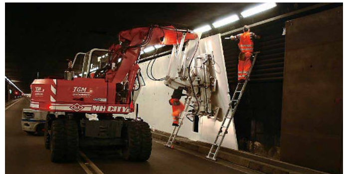
Montage des nouveaux panneaux à l'aide d'un engin à vacuum
