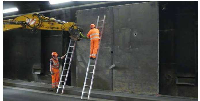
Démontage des panneaux endommagés. Leur surface poreuse ne permet pas l'utilisation de l'engin à vacuum.
