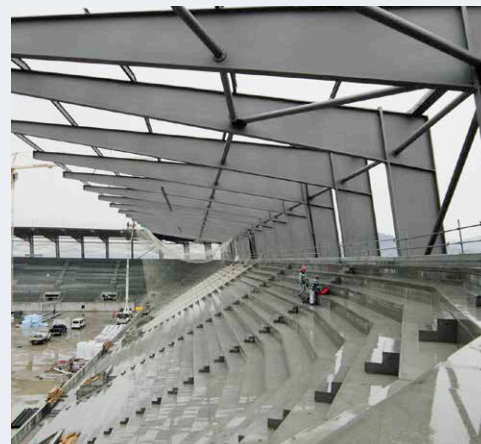
Les sièges ont nécessité 18'000 vis à béton MULTI-MONTI et 36'000 boulons d'ancrage.
