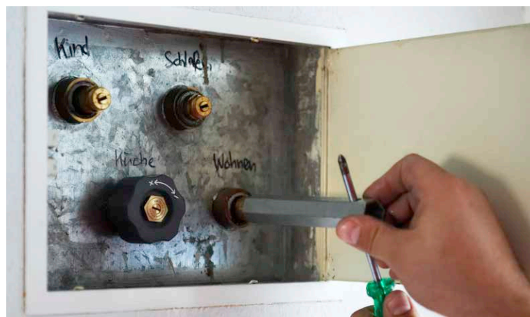
Montage des nouvelles têtes de vannes.
